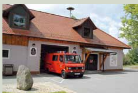
Das Gerätehaus der Feuerwehr Hütten. In der Garage steht ein TSF von 1993. Der Mercedes 310 wurde von der Firma Paul Ludwig in Bayreuth ausgerüstet.
